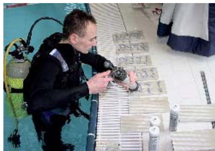
Die Dicht- und Klebmasse trugen Zitzelsberger und Erndl außerhalb des Wassers auf die Plattenrückseite schlangenförmig auf...
