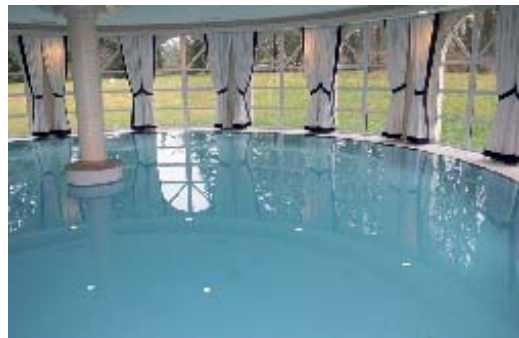
Die Durchführung der Ausbesserungsarbeiten verursachte weder Lärm noch Dreck. Die Hotelgäste konnten den übrigen Spa-Bereich uneingeschränkt nutzen.
