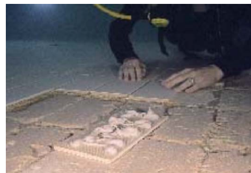
Die Dicht- und Klebmasse trugen Zitzelsberger und Erndl außerhalb des Wassers auf die Plattenrückseite schlangenförmig auf...
