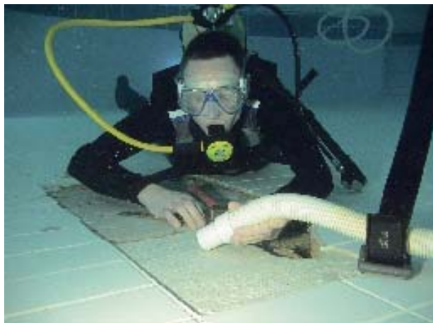
Der Absaugschlauch des Beckens wurde umfunktioniert, um Schwebeteilchen abzusaugen, damit diese nicht die Sicht bei den Arbeiten behinderten.
